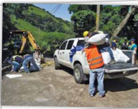
10/08/12. Personal de CONAVI realizando muestreos de material del camino y tajos para el proyecto de la pavimentación.
