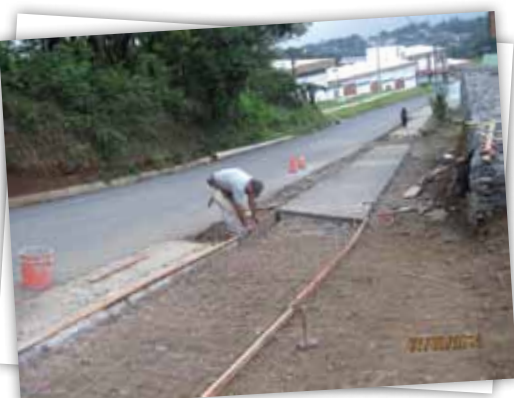
Construcción de aceras frente a Correos de Costa Rica
