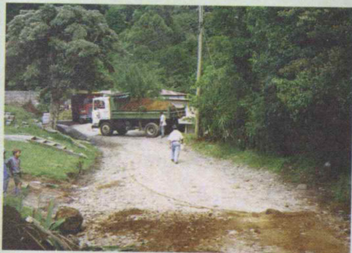
Primeros trabajos de adoquinado en las calles de Santa Elena, proyecto de ADISE.
