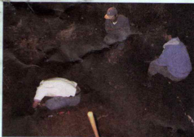
La trabajadores de nuestro Acueducto, no solo debe satisfacer la demanda del servicio en el presente, sino, que deben velar por la calidad de los trabajos en el acueducto para garantizarla a del futuro.
