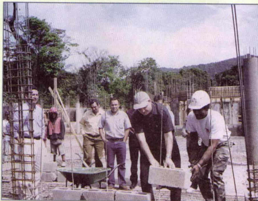
El presidente de la CCSS, Dr. Rodolfo Piza Rocafor, el pasado 16 de diciembre de 2000; procede simbólicamente a poner la primera piedra en la construcción de la nueva clínica.
