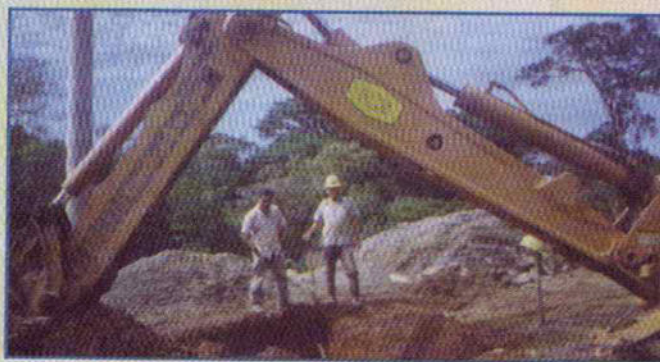
Cuadrilla del ICE haciendo las mejoras en el trayecto que comprende el Proyecto de Pavimentación.
