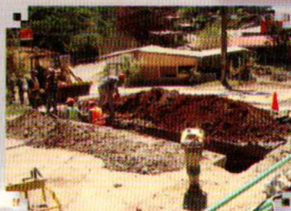
Colocación de tubería de distribución por el Cruce del Tucán.
