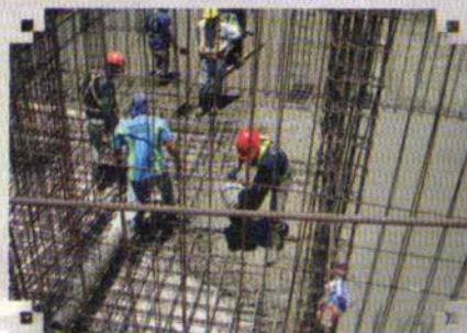
Proceso de construcción de la losa inferior del Tanque de 300m 3 ubicado por Condominio Villa Azul.
