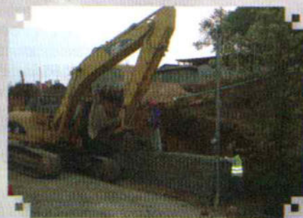
Trabajos en muros de gaviones en Bajo Rodríguez.
