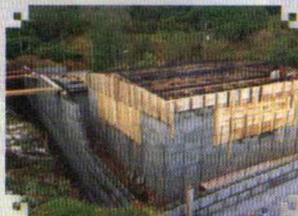
Caseta de Bombeo en Bajo Rodríguez.
