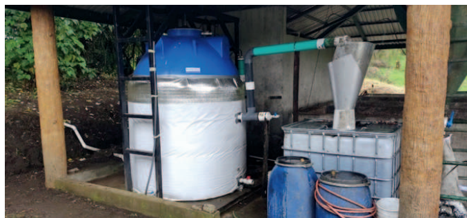
Prototipo de un biodigestor anaerobio diseñado por la Escuela de Ingeniería de Biosistemas de la Universidad de Costa Rica
