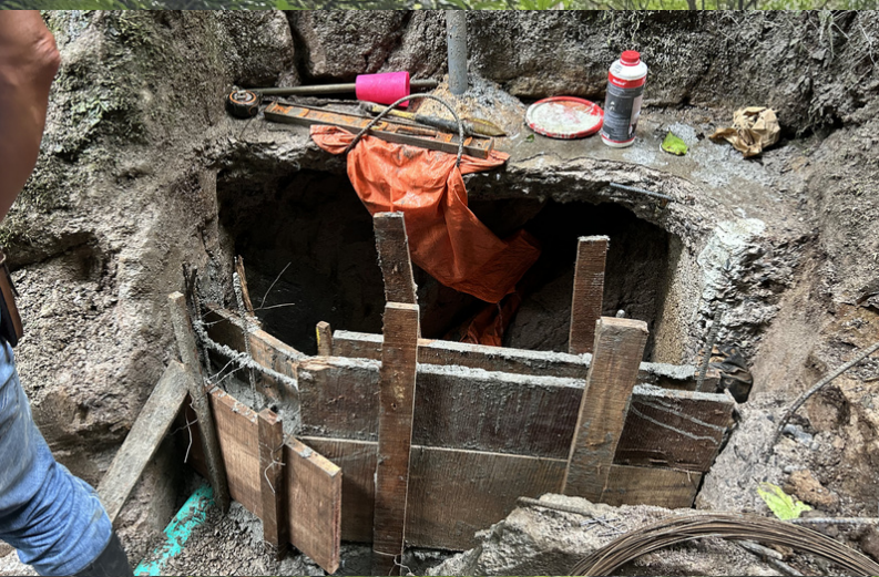
Conformación de la caja de captación.
